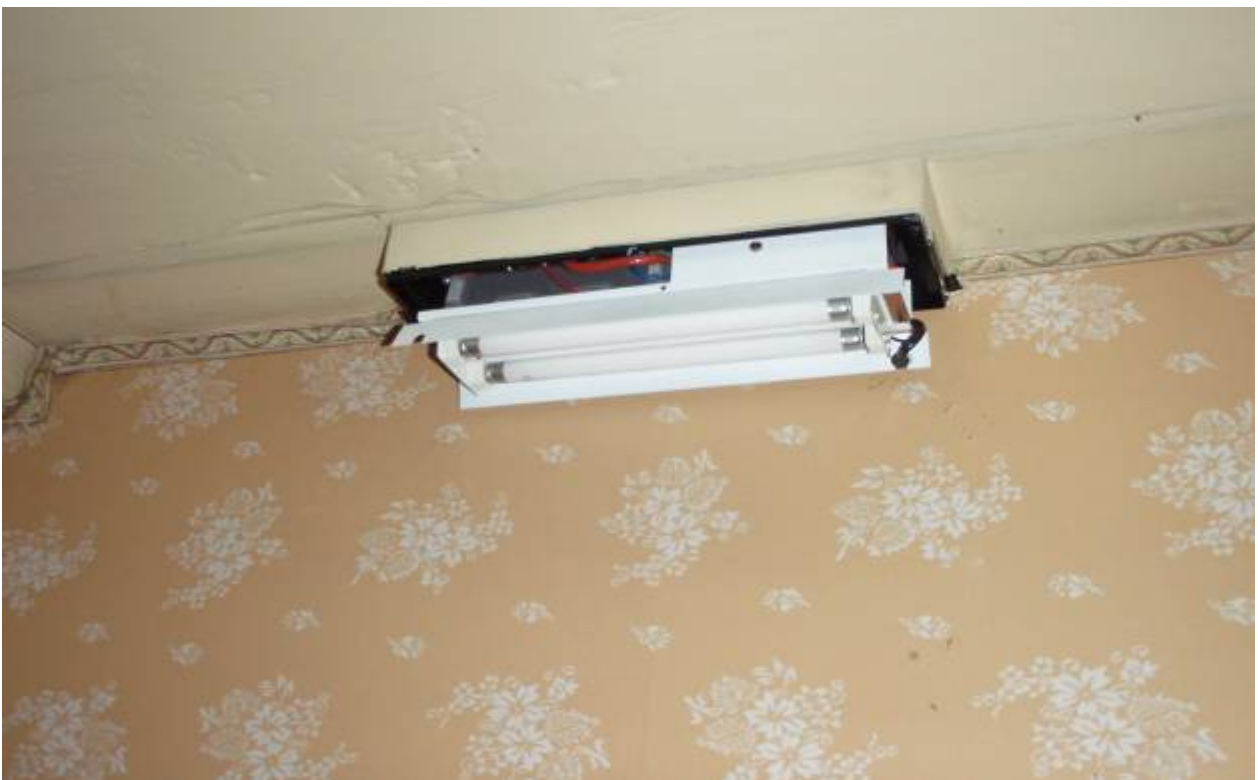
S-KUVA 10. poistumistie/turvavalaisin
