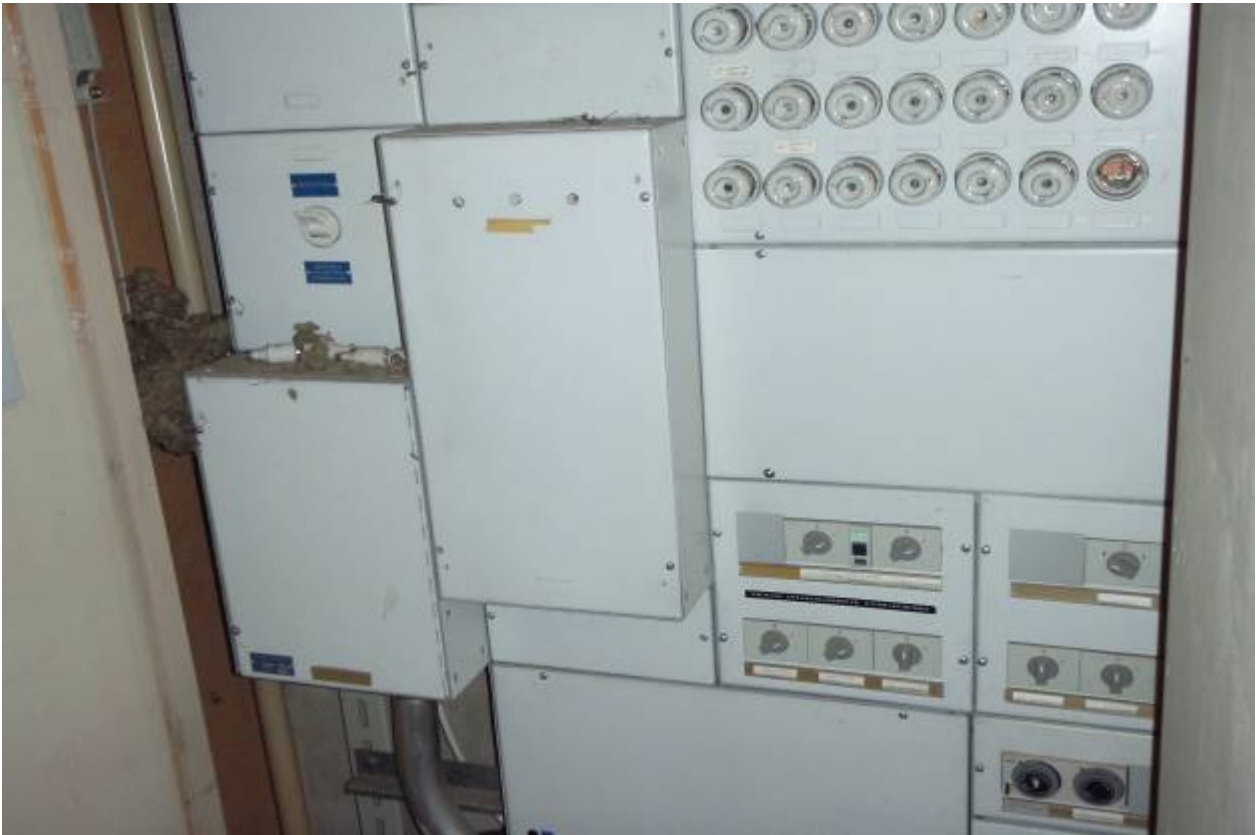
S-KUVA 3. Sähköpääkeskus
